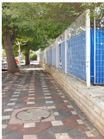
תמונה מס' 3 : תוואי כבל החשמל התת קרקעי לאורך הגדר המזרחית של הגן
